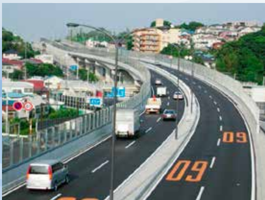
図1 ポーラスアスファルトと埋設ジョイントの技術を適用した環境フレンドリー舗装の一例
