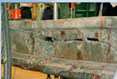
図1 塩害で劣化した実構造物の載荷試験
